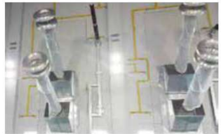
복당진-고덕2단계 부상마감플레이트 제작, 설치
